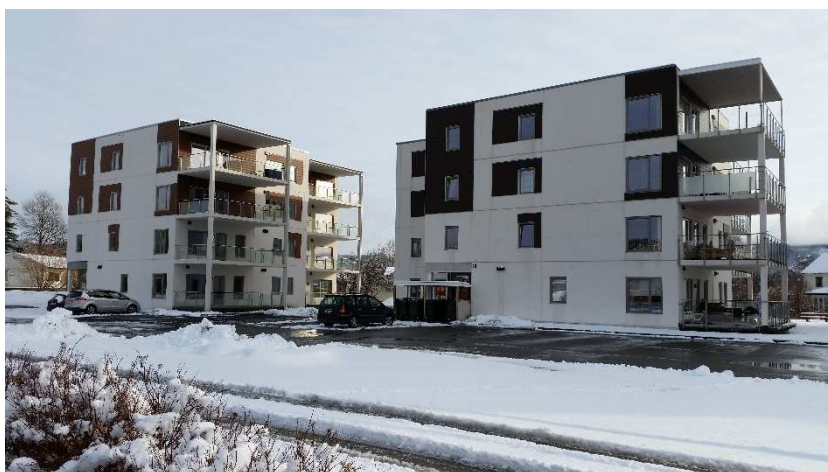
Det siste av 3 leilighetskompleks i Rissa sentrum (bygget til venstre i bildet) ble innflytningsklart i begynnelsen av februar 2017. Petter Bakøy AS har stått for oppføringen av alle 3 bygg.
